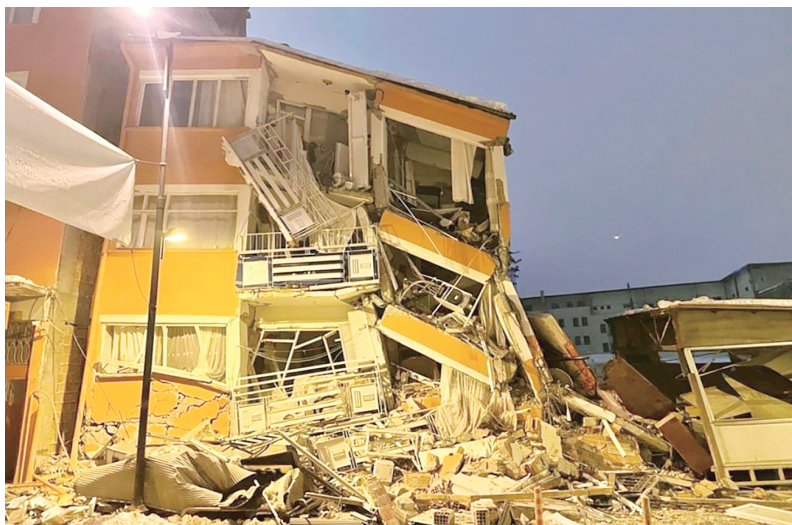
这是2月6日在土耳其卡赫拉曼马拉什省帕扎尔哲克拍摄的受损建筑物。据最新消息，强震已造成叙利亚阿勒颇省、拉塔基亚省、哈马省、塔尔图斯省等叙中北部省份共237人死亡、639人受伤。新华社发
