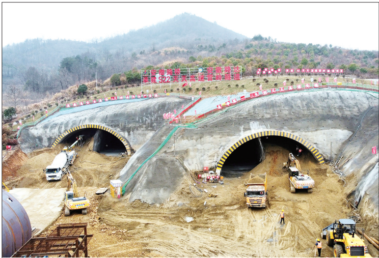
2月25日,怀宁县石镜乡营岭隧道项目工地上,工人们正在加紧施工。营岭隧道项目是S22天天高速安庆至潜山段控制性工程,全长1680米,总投资5.9亿元,采取分离式隧道布局,为安徽省最大断面三车道高速公路隧道。截至目前,隧道安庆端左、右线洞顶截水沟、边仰坡防护、超前大管棚支护均已完成,正在进行左、右洞洞身开挖支护施工。
