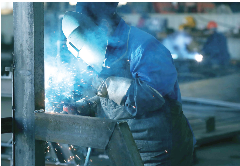
4月6日,桐城市文昌工业园一家重工机械有限公司车间内,工人们忙着切割、焊接、装配,有条不紊、井然有序。近年来,在当地政府的支持下,公司先后投入500余万元对原车间进行了技术改造调整,新增了部分智能设备和环保装备,促进公司提质增效。2022年公司完成工业产值4000多万元。 全媒体记者 储永志 通讯员 周永丽 摄
