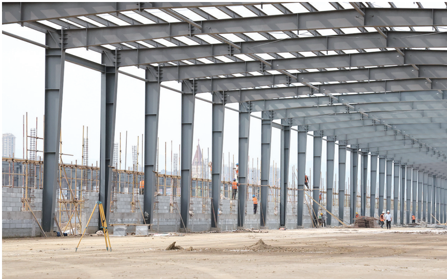
桐城国轩新能源公司二期项目施工现场。
