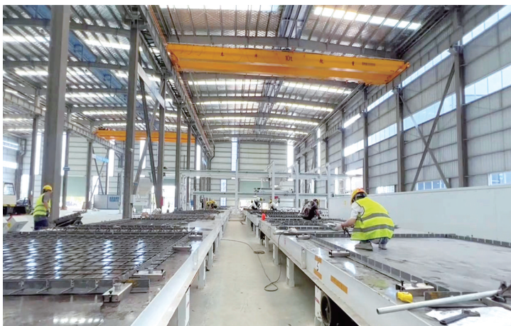
生产车间内工人正在作业。 付为胜供图
