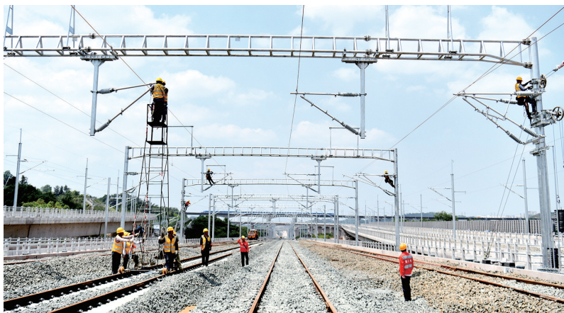
5月23日，在成宜高铁宜宾站，施工人员在架设接触网。
