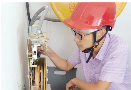
唐熊武检查电梯限速器
