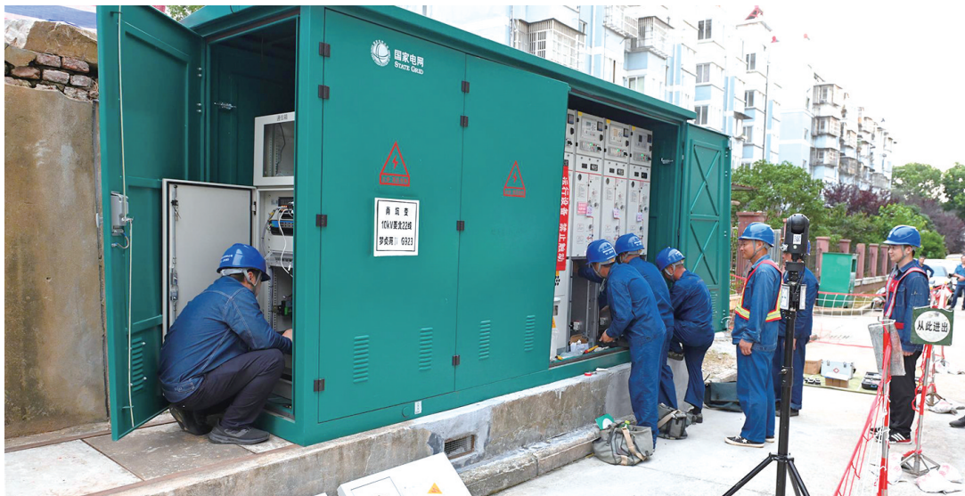
7月4日,在梦祯苑小区双电源改造工程现场,工作人员正在进行最后一台新装高压环网柜改接及自动化调试工作。梦祯苑小区双电源改造工程项目是国网安庆供电公司为了实现梦祯苑、华茂新园等老旧小区高质量可靠供电的民生工程。改造完成后,能彻底改变老旧小区停电多、故障恢复慢等老百姓最关心的民生用电问题。
