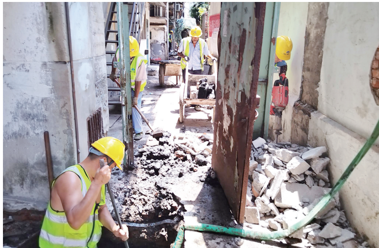
工人在阳光花园一期施工现场忙碌。
