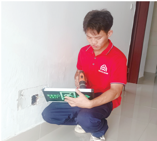
朱庆在维修福利院内设施。
