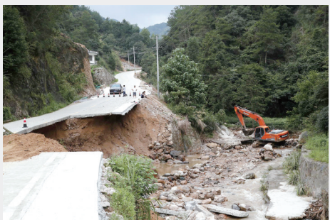
挖掘机在风景村恢复交通。
