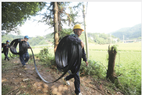
国网潜山市供电公司电力工人抢修电力。
