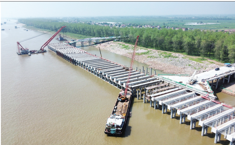
安庆港中心港区皖河新港一期工程是安庆市首座万吨级码头,位于安庆市望江县漳湖镇漳湖闸下游。截至目前,码头主体建设进度已完成75%左右,主体完工后将进入码头装卸设备安装环节。
