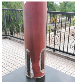
▲为亭子损坏明显,立柱钢筋裸露。 ▲长廊斑驳陈旧,顶端的横梁发黑。
