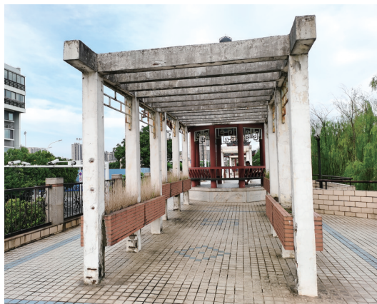
▲为亭子损坏明显,立柱钢筋裸露。 ▲长廊斑驳陈旧,顶端的横梁发黑。
