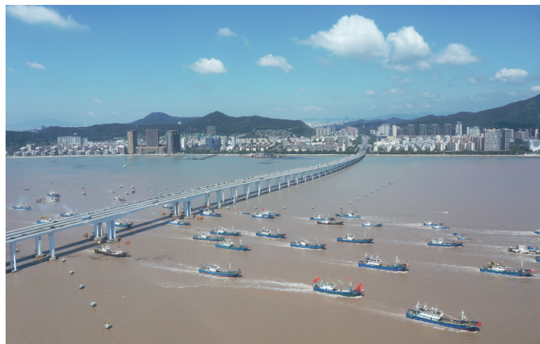
8月6日，渔船驶过浙江省舟山市普陀区朱家尖跨海大桥，奔赴东海开捕（无人机照片）。
