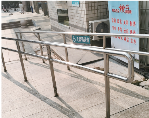
▲市立医院门诊大楼一楼设置的无障碍通道
