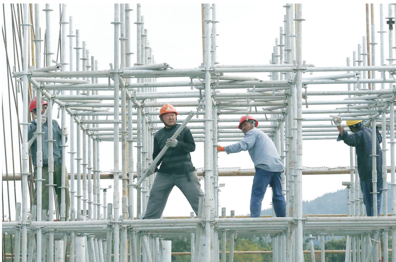
10月9日,宿松县佐坝乡智慧云仓电商示范园建筑工地一片繁忙的施工景象。该项目总用地60余亩,新建服装云仓约60000平方米。项目建成后,将为园区客户提供代发、采购外包、云仓仓储、直播云仓、电商仓储托管等一体化云仓供应链服务。
