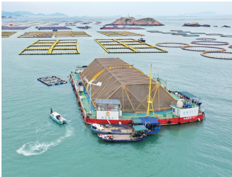
这是10月10日拍摄的福建省连江县定海湾内的“定海湾1号”深远海养殖平台（无人机照片）。
