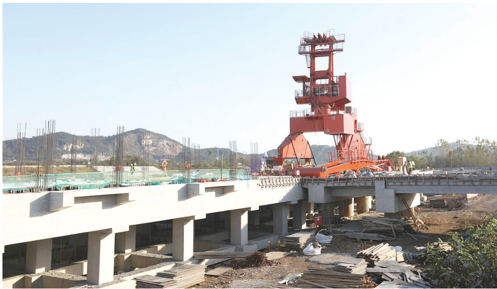
11月8日,石门湖一期工程项目现场。 全媒体记者 徐火炬 摄
