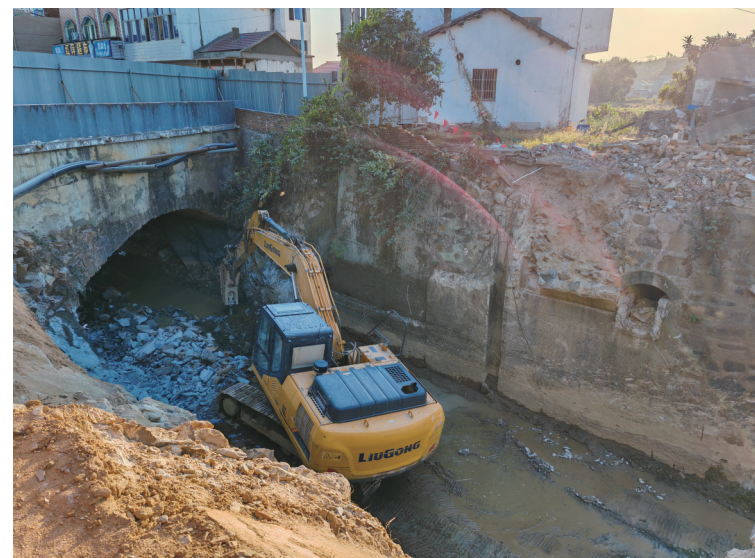
黄大枢纽进水闸工程现场。
