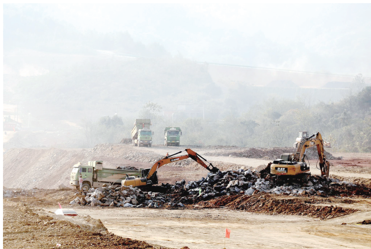
山口片区基础设施建设项目（一期）标段5号地块，工程车辆往来穿梭。
