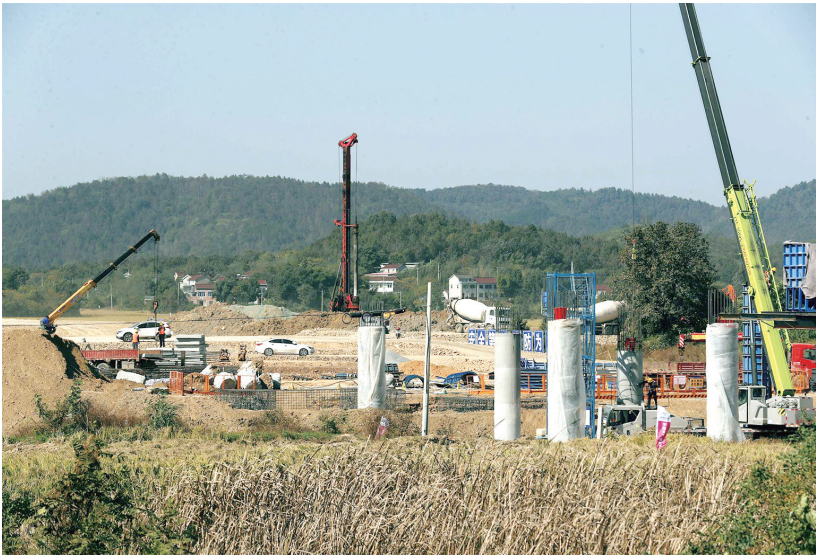
11月12日,S22天天高速安庆罗岭段工地上,机器轰鸣,工人顶着寒风浇筑桥墩,工程项目有序推进。S22天天高速线路全长约400公里,起点在滁州市天长,终点在安庆天柱山。项目工期预计三年,竣工运行后对促进长三角地区各城市间经济、文化交流互通具有重要作用。 全媒体记者 储永志 通讯员 蒋陶陶 摄
