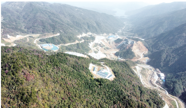
桐城抽水蓄能电站工程施工现场。 全媒体记者 徐火炬 摄
