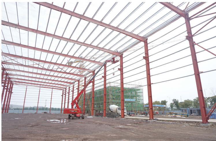
迎江经开区祥路中天超强钢新材料产业园一期项目正在进行钢结构厂房安装。 通讯员 杨磊 摄
