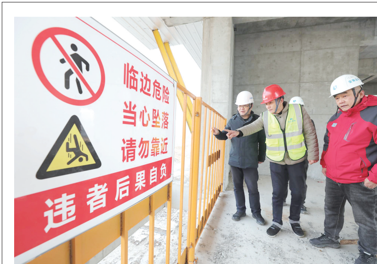
12月20日,市建管处工作人员在皖江大道一处建筑工地对楼层定型化防护进行检查。
