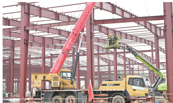
12月14日,中环新能源20GW高效电池生产制造项目建设现场
