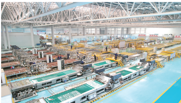
12月20日,中建材桐城新能源材料有限公司车间。
