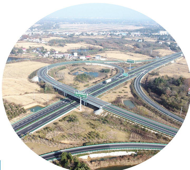
12月7日，鸽子墩枢纽航拍图。
