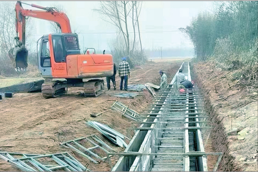
1月2日,桐城市新渡镇永久村高标准农田施工区,施工人员正在建设引水渠。
