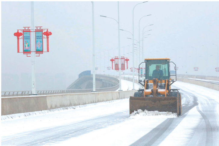
2月6日,铲雪车在高新区勇进路大桥开展除雪防滑保畅作业。
