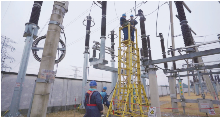
国网安庆供电公司员工正在融冰保供电。
