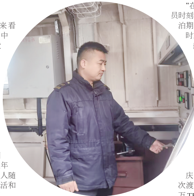
周立献在检查船舶机舱主配电板。
