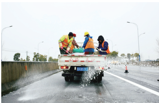
市公路中心工作人员在国道347海口段撒布融雪剂。
