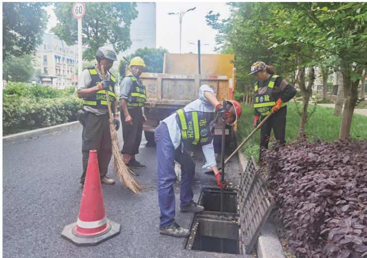
独秀大道市政工作人员正在对雨水井进行清掏作业。
