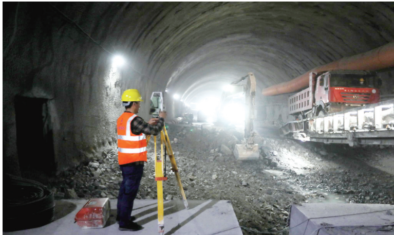
范海在营岭隧道内进行测量。
