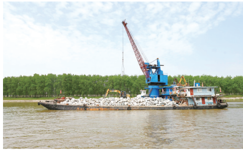
4月24日，施工船正在作业。
