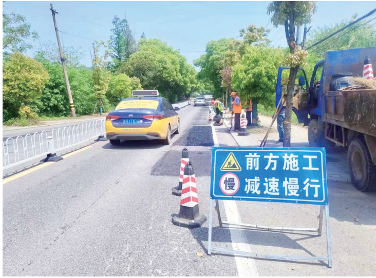
工人在养护修复破损路面。 通讯员 黄娟 供图
