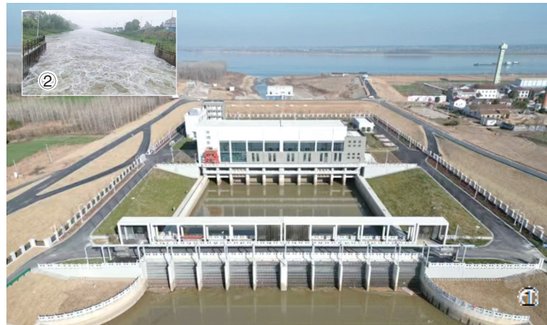
①望江县漳湖排涝站航拍图。②为漳湖闸上游来水。
