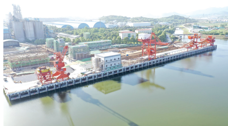
石门湖一期码头主体等建设完成。图片由通讯员提供
