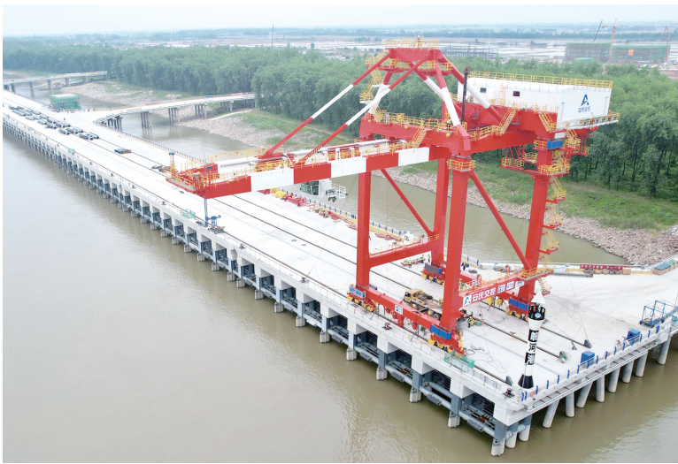
安庆港中心港区皖河新港雏形初显，码头平台已安装大型装卸设备。
