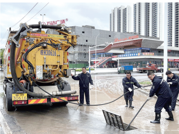
市政部门工作人员在道路上抽排积水。
