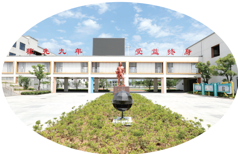
怀宁县稼先学校。
