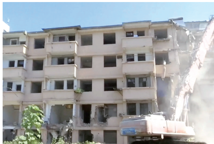
7月5日上午,老汽车站3号楼正式拆除。全媒体记者 方亮 摄
