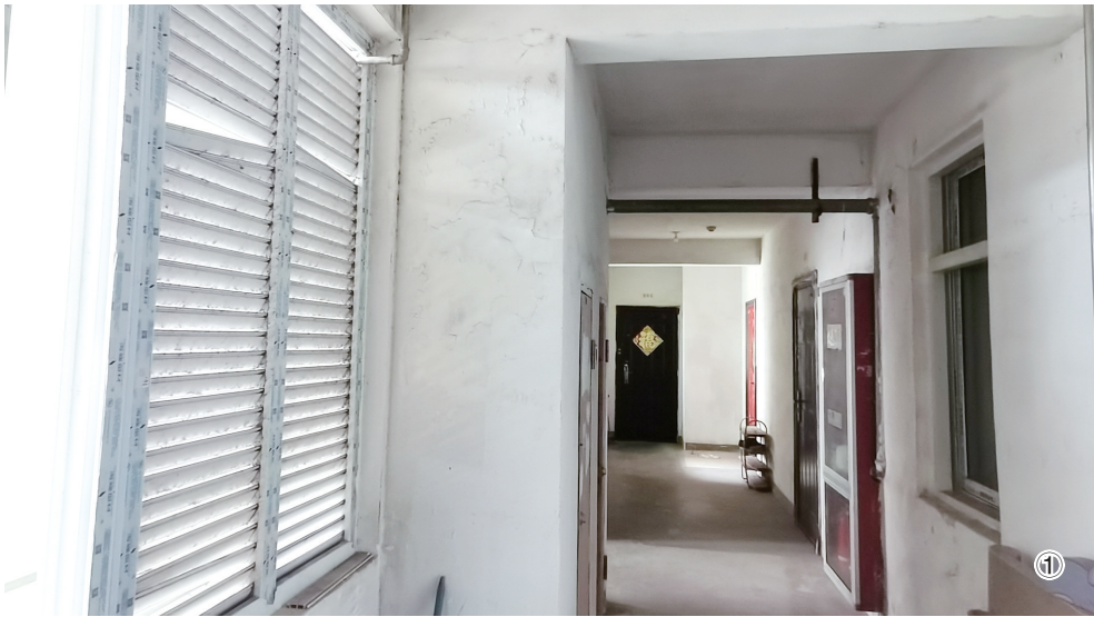
①3号楼楼道内已改造的固定百叶窗。
