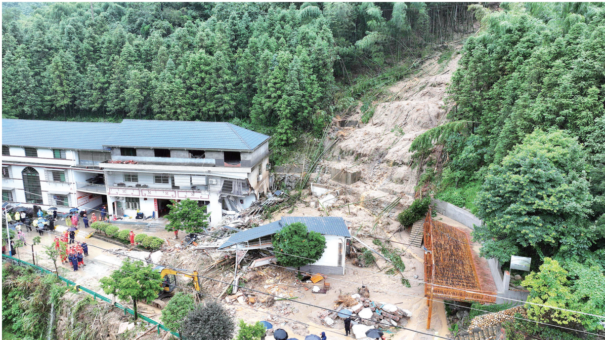
这是7月28日在衡阳市南岳区寿岳乡岳林村拍摄的山体滑坡现场(无人机照片)。新华社 发
