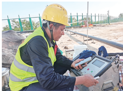
刘团结设置好加热温度和时间,进行管口热熔。
