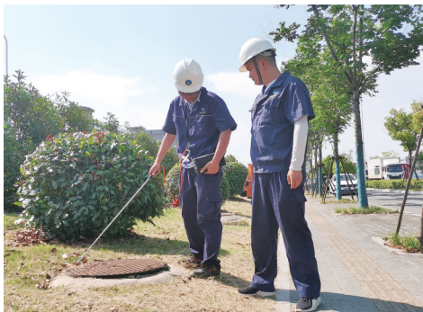
梅子聪(左)和王智勇进行探漏作业。
