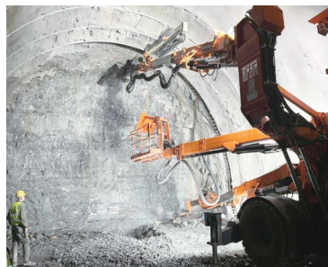
渝湘复线高速公路彭水隧道施工现场。（受访单位供图）
