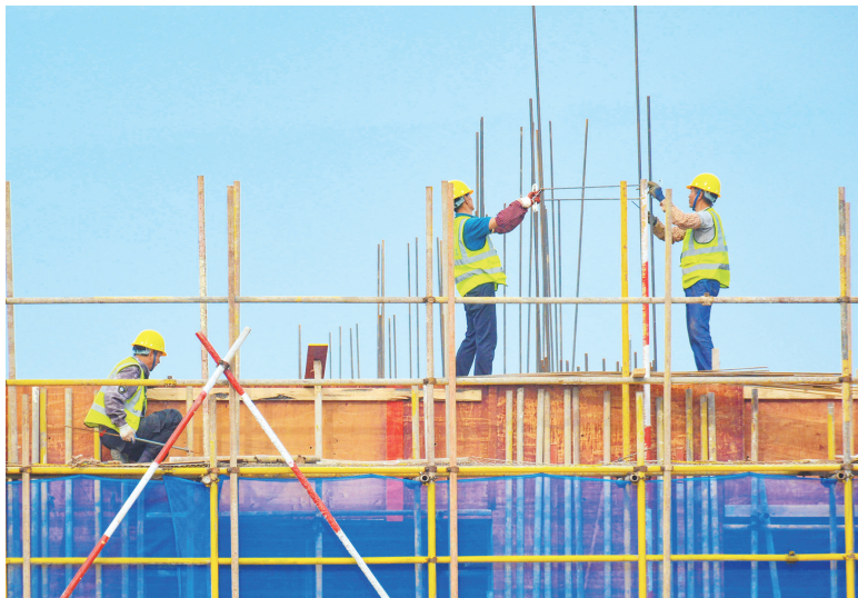
10月28日,在岳西翠兰绿色发展示范园项目建设现场,工人们正在加紧施工。
