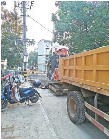
挖土机、货车正在施工作业。
