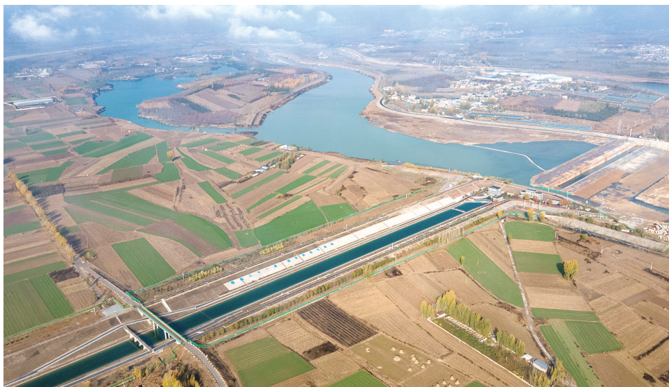
这是位于京冀交界处的北拒马河暗渠工程（无人机照片，11月14日摄）。“南水”由河北段明渠经北拒马河暗渠进入北京。 新华社 发
