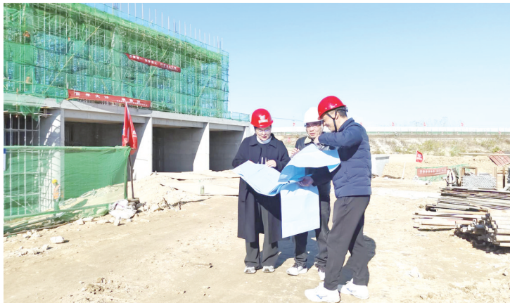
怀宁县马踏石闸加固工程施工现场。
