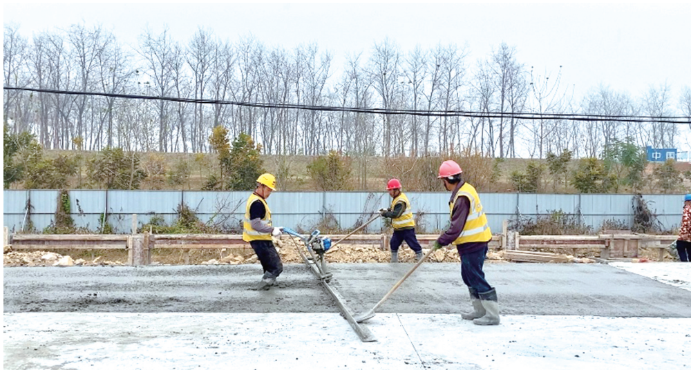
皖河新港一期工程施工现场
